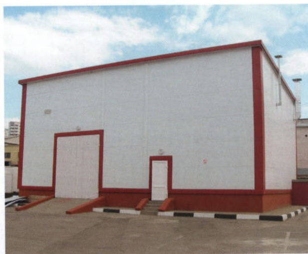
Рис. 1. Павильон локальной очистной станции
