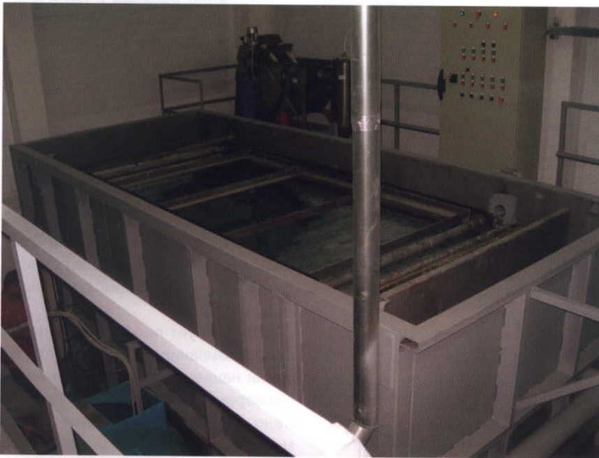
Рис. 3. Аэрируемый жироседелитель-отстойник
