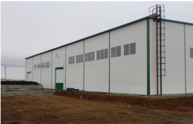
Рис. 1. Внешний вид здания ЛОС
